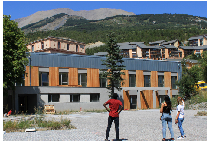
Maison de santé de Barcelonnette en Bois des Alpes
